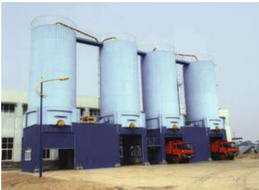
4 silos de 250 m³ de capacidad y 5,5 m de diámetro cada uno para la carga de camiones (Hangzhou, China)
