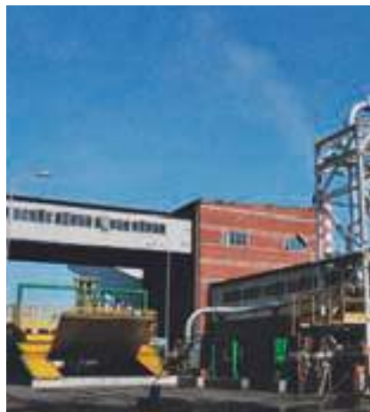
Sistema de recepción de lodos de carbón en la central termoeléctrica
