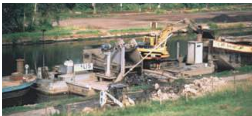
Instalación de trasiego de lodos con tubo oscilante "S" y grupo hidráulico de gasóleo, montada sobre un pontón; actuación en un canal en Bélgica
