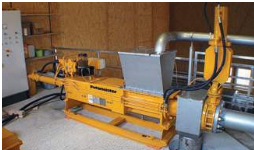
La EKO 1060 PP en la instalación de biometanización en Kössen, Austria, para el transporte y desembalaje de alimentos caducados
