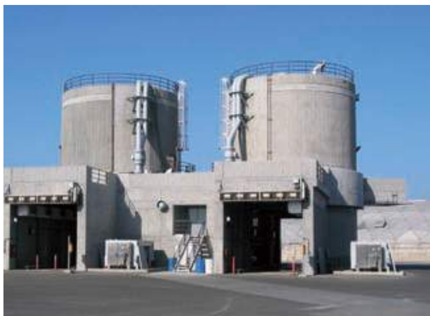
Silo de carga de camiones, fabricado en hormigón (Orange County, California)
