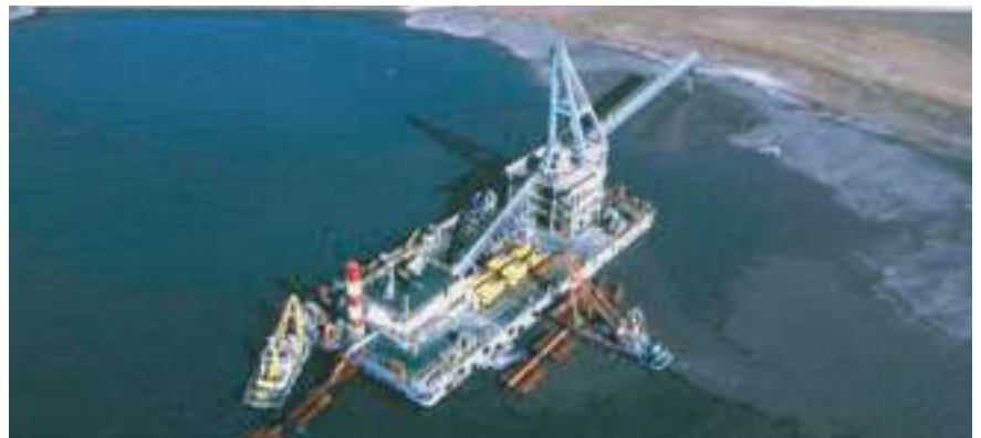
Tres bombas de pistón enormes, KOS 25100 y 25200 transportan material de draga para ganar terreno hacia la costa de Japón. La nueva isla artificial alojará al aeropuerto de Nagoya.
