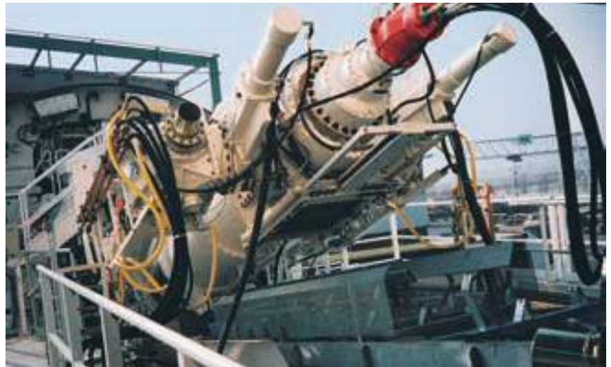
Transportador sinfín con dos bombas de escombros tipo KOS 1480, túnel Botlek
