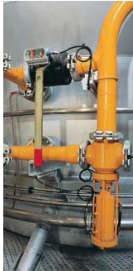
Entrada de lodo activado en un horno de lecho fluidificado
