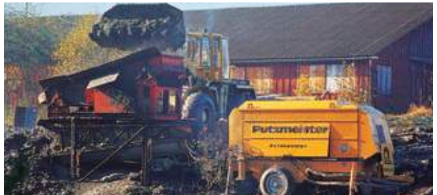
Instalación de bombeo y tratamiento de lodo de río
