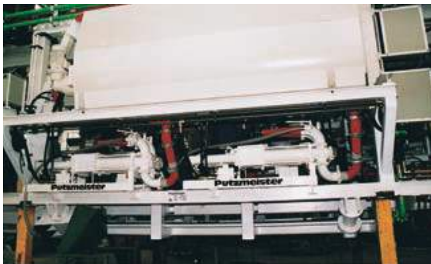
Instalación compacta de dos KOV 550 DUO bajo una artesa de 6 m 3 en Singapur, para la inyección del anillo de entibado
