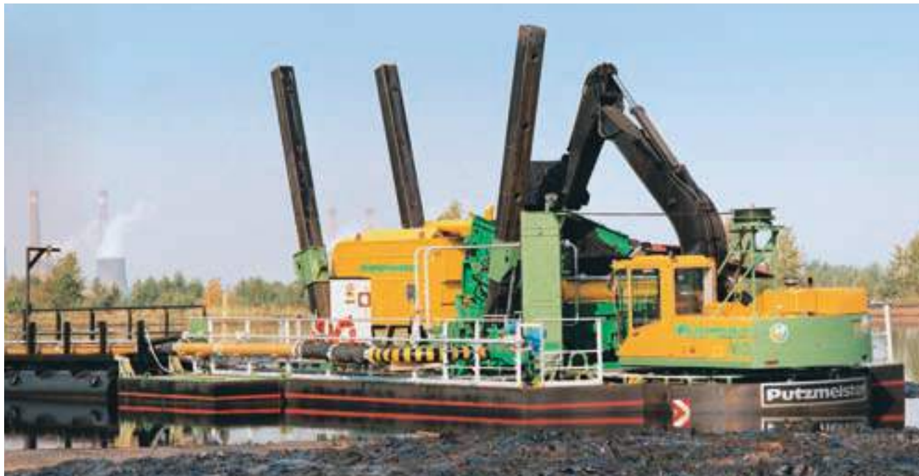
Limpieza de un depósito de alquitrán con una draga flotante Dredgemaster controlado a distancia
